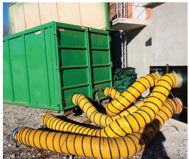
Abb. 2: Prinzipieller Aufbau eines Satzrockners: Links schematisch, rechts in der Praxis
